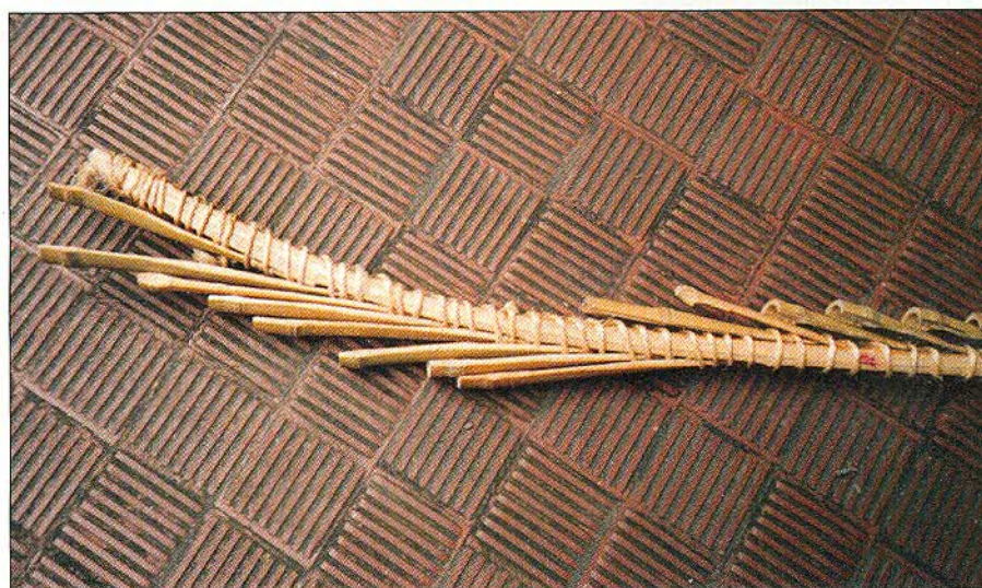
Nelle foto: (sopra) arco completato, struttura in fase di montaggio e (sotto) dettagli del sistema di legatura, con i cunei inseriti uno dietro l'altro.
